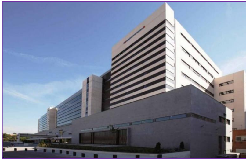
HOSPITAL 12 DE OCTUBRE
